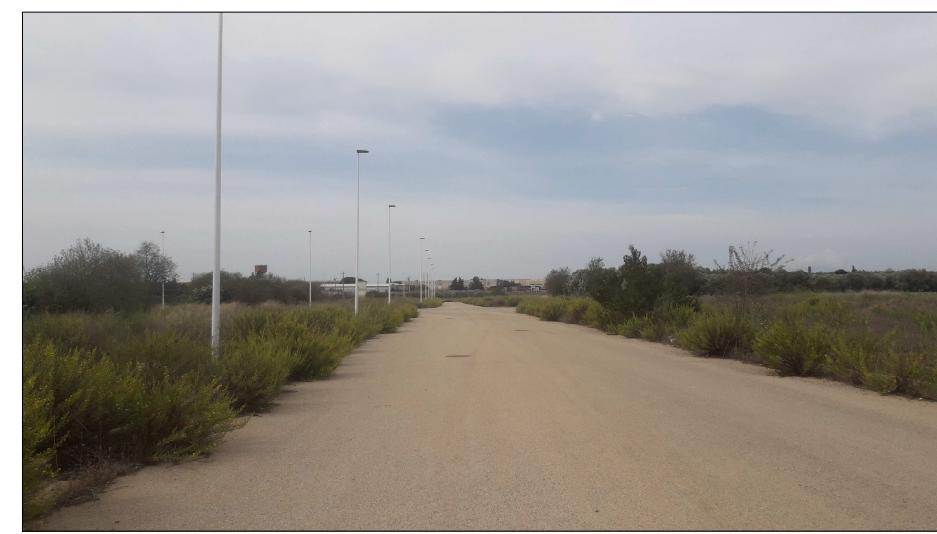
Foto 1 - Particolare strada di piano - Vista nord-ovest
