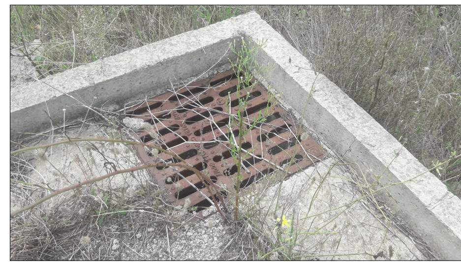
Foto 7 - Particolare caditoia per acque meteoriche
